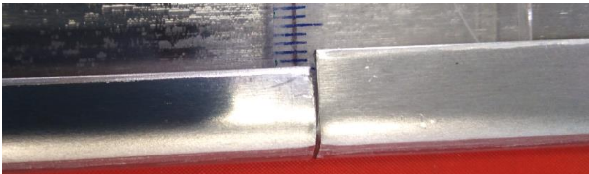
Fot 1. Wywinięcie blachy.
